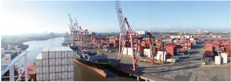
Die Zufahrt zum Container Terminal
